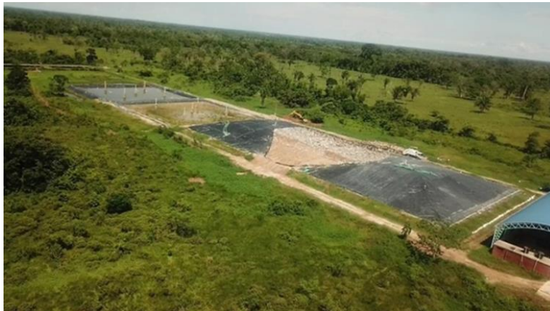
Ilustración 16. Relleno Sanitario regional vereda La Ceiba
