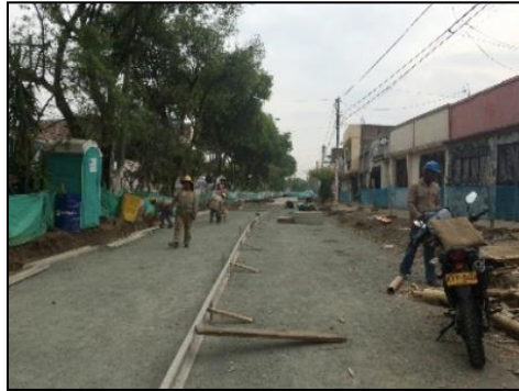
Imagen No.1 Instalación de formaleta
