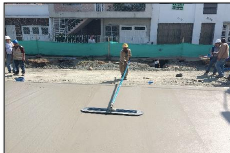
Imagen No.4 Flotado de Concreto
