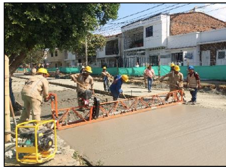
Imagen No.3 Extensión de Concreto con Regla Vibratoria
