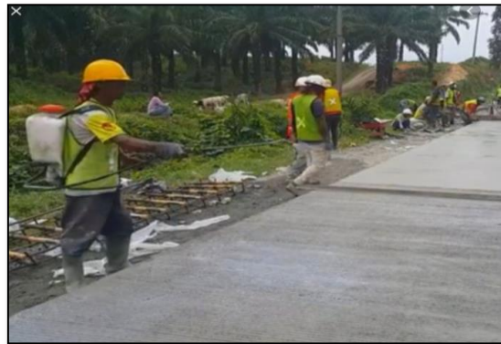
Imagen No.6 Flotado de Concreto
