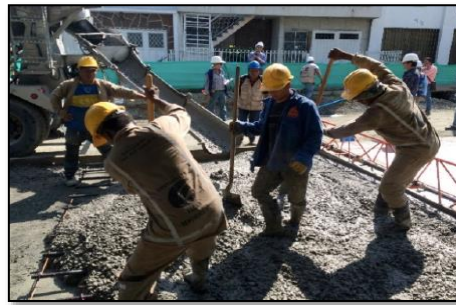
Imagen No.2 Disposición de la mezcla.
