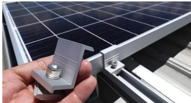
Ilustración 7 Instalación END en el panel solar
