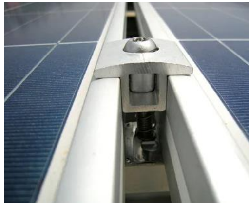
Ilustración 5 Instalación del MID en el panel solar
