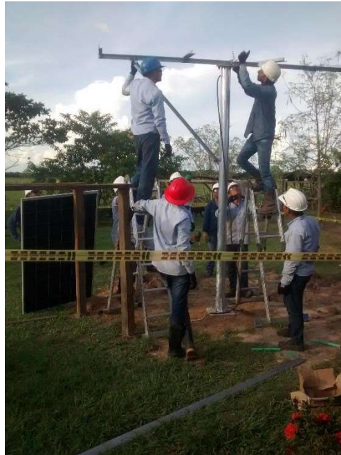
Ilustración 3 Armado de estructura soporte módulos solares
