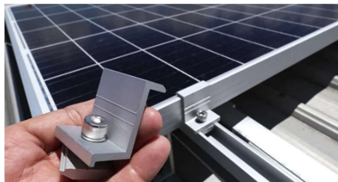
Ilustración 11 Instalación END en el panel solar
