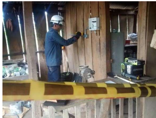
Ilustración 18 Instalación de redes eléctricas internas
