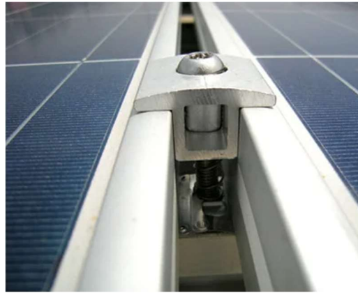
Ilustración 9 Instalación del MID en el panel solar
