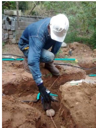
Ilustración 14 Excavación e instalación de Sistema de Puesta a Tierra
