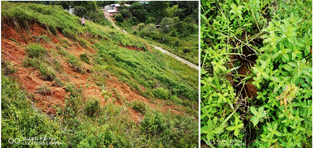
Imagen 3 Estado actual del talud de estudio
