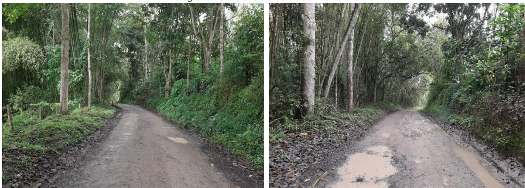
Fotografía 10. Estado del tramo de intervención
