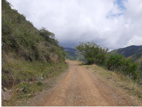
Fotografía 8. Estado del tramo de intervención
