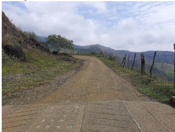
Fotografía 1. Estado actual del tramo de intervención – K2+570
