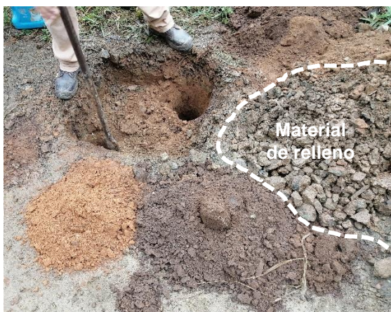
Foto 12 Material de relleno antrópico usado como afirmado en la unidad de diseño N°2 del tramo N°2 Fuente: El Autor
