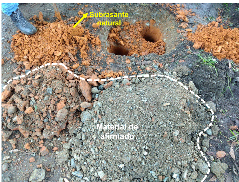
Foto 14 Material de relleno y subrasante natural encontrada en la unidad de diseño N°1 del tramo N°2 Fuente: El Autor
