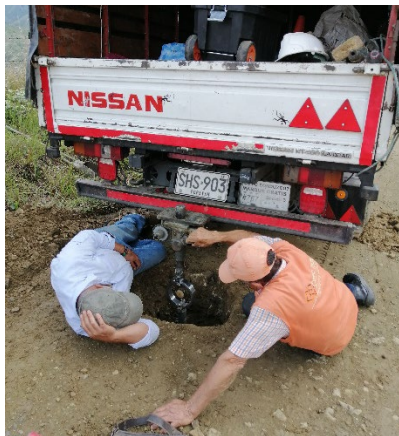
Foto 6 Ejecución del CBR de campo Fuente: El Autor
