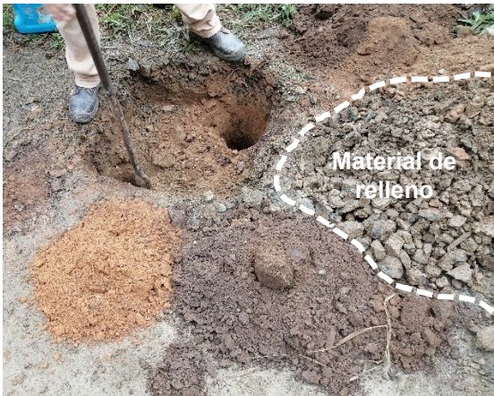
Foto 12 Material de relleno antrópico usado como afirmado en la unidad de diseño N°2 del tramo N°2 Fuente: El Autor
