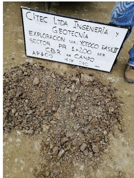
Foto 11 Subrasante natural encontrada en la unidad de diseño N°1 del tramo N°1
