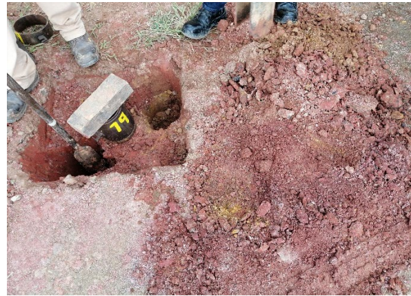
Foto 13 Subrasante natural encontrada en la unidad de diseño N°2 del tramo N°1 Fuente: El Autor
