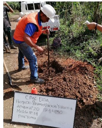
Foto 7 Apertura de apiques Fuente: El Autor
