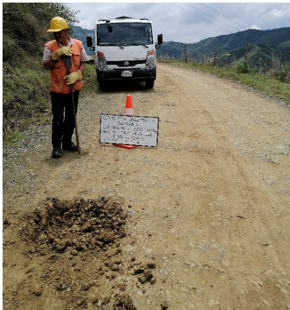
Foto 10 Material de relleno antrópico usado como afirmado en la unidad de diseño N°2 del tramo N°2
