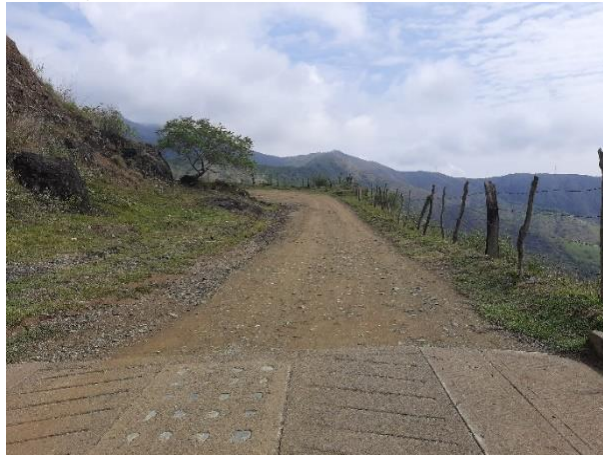
Fotografía 1. Estado actual del tramo de intervención – K2+570
