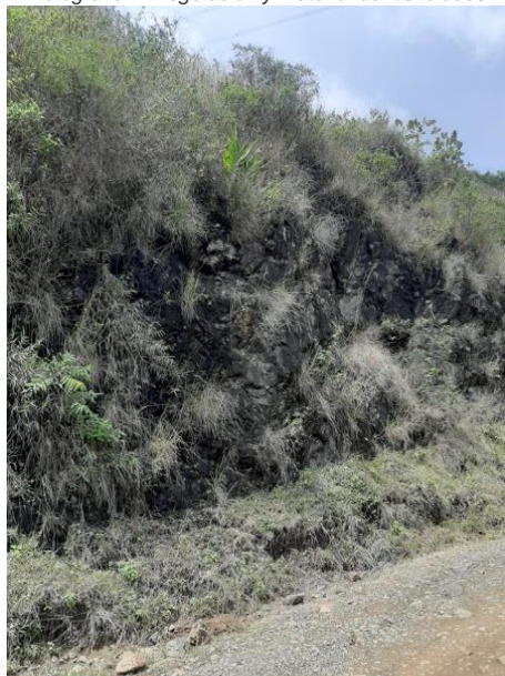
Fotografía 7. Vegetación y material de los taludes
