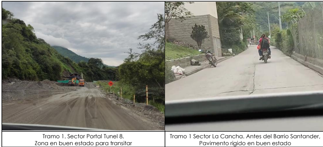
Fotografía 1. Registro de la vía para el Tramo 1 (Elaborado por GICA SAS)
