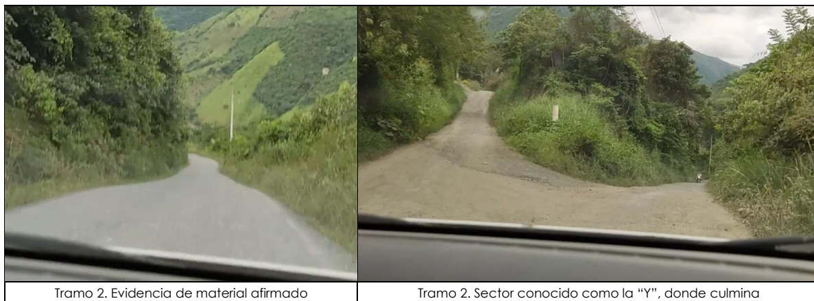
Fotografía 2. Registro de la vía para el Tramo 2 (Elaborado por GICA SAS)
