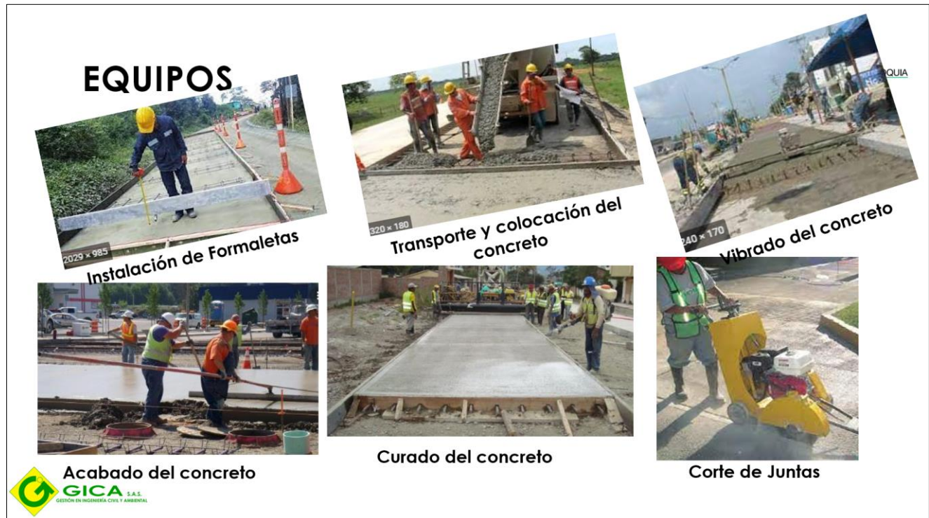
Figura 6. Equipos usados en construcción de pavimento rígido
