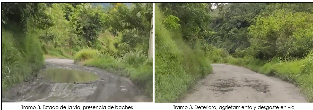
Fotografía 3. Registro de la vía para el Tramo 3 (Elaborado por GICA SAS)
