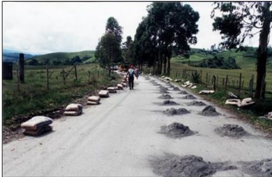
Fotografía 1. Homogeneización superficial del cemento
