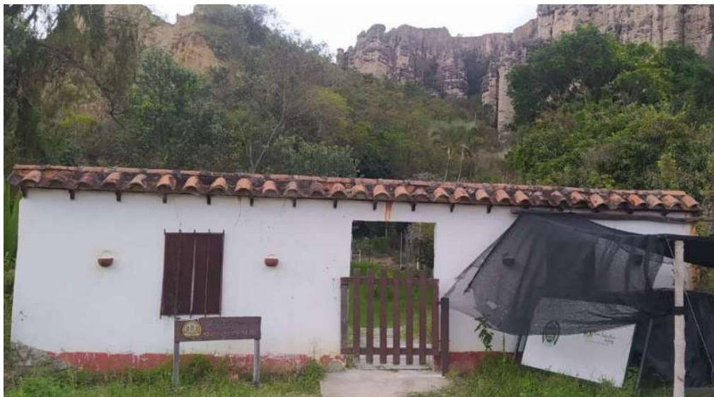
Portada existente al ANU Los Estoraques
