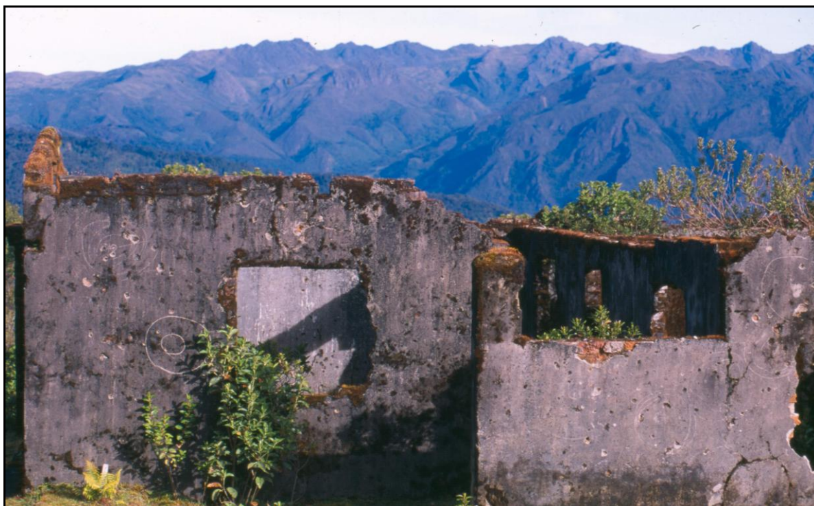
Pabellón de fusilamiento. Foto R. Ariano
