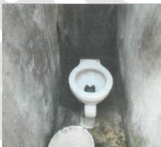
Cocina sin mesón adecuado, solo una mesa. / Baño sin un sanitario adecuado y esta sin tanque.
