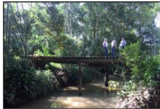
PUENTE EXISTENTE Q. MARIMBAS
