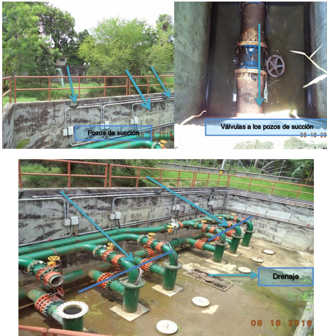
Ilustración 25. Pozos de succión que bombean a los tanques 20 de enero y Laureles
