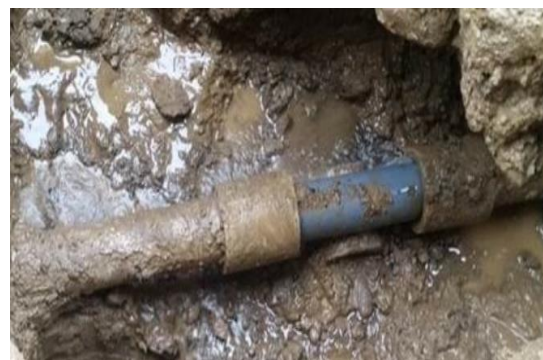
Ilustración 43 Reparación de Fuga 3" asbesto cemento, circuito 45/387180. CI 98 entre Cr 99 y Cr 100.
