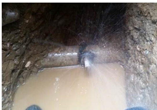
Ilustración 42 Reparación de Fuga 3" asbesto cemento, circuito 45/128300. Cr 103 entre CI 98 y CI 99.
