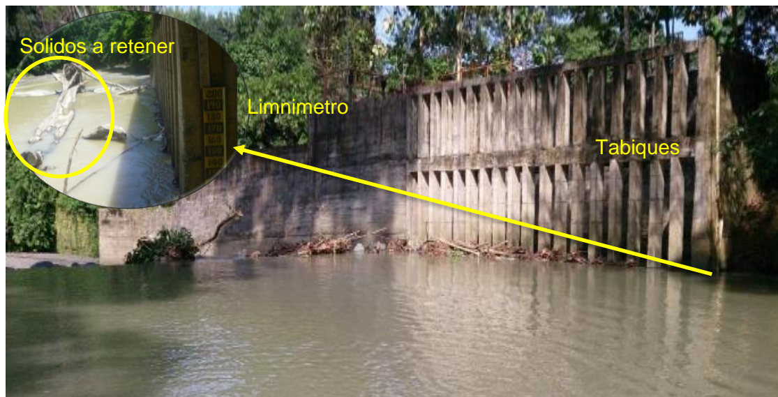
Ilustración 5. Captación por estructural lateral
