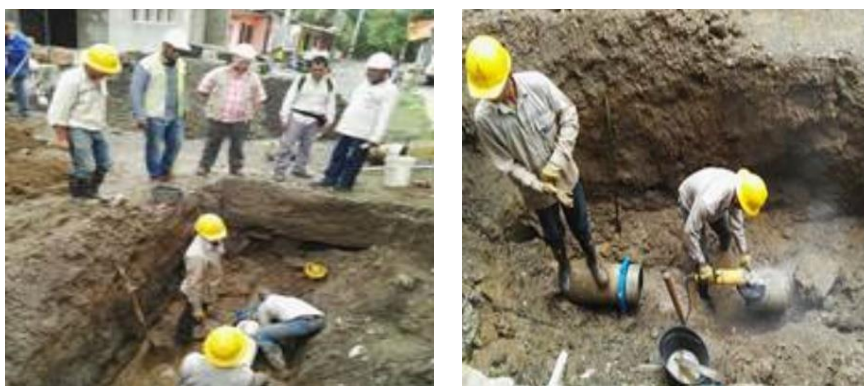
Ilustración 45 Reparación de fuga 10" frente al circuito 045/394900 al lado de Foto Quintero es producto de unión de asbesto cemento en mal estado. Carrera 98 entre Calle 99 y Río Apartadó.
