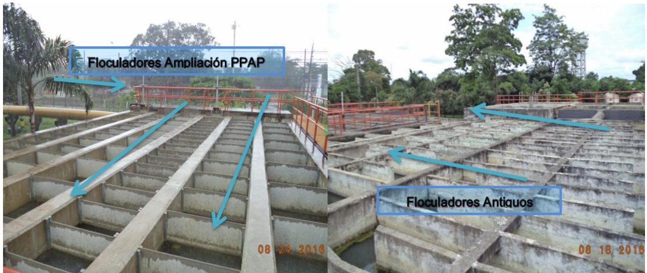
Ilustración 16. Floculadores verticales y horizontales.
