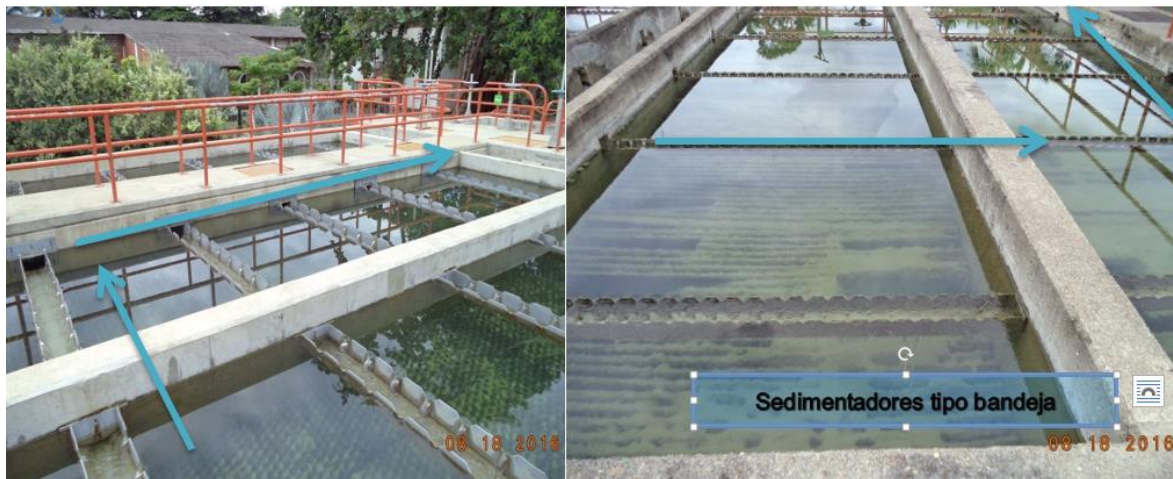
Ilustración 17 Sedimentadores tipo colmena y tipo bandejas
