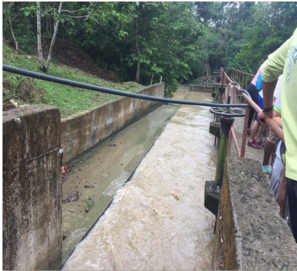
Ilustración 7. Desarenador y rebose ubicado en la Bocatoma
