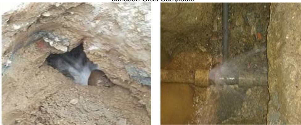
Ilustración 40 Reparación de Fuga 3" asbesto cemento, circuito 045/420700 – 420720, Cr 101A entre Calle 97 y Calle 98. Entre las Molas y el Arcoíris
