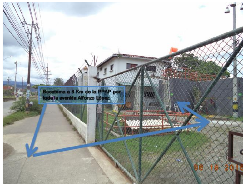
Ilustración 10 Entrada conducción a la PPAP por la avenida López con un trayecto de 6Km
