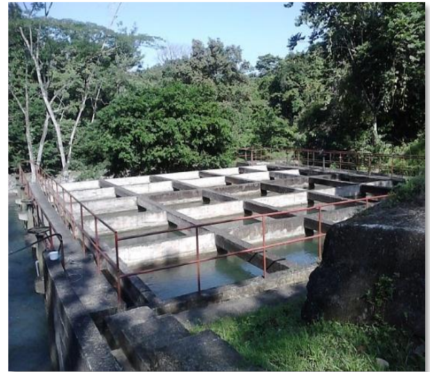
Ilustración 7. Desarenador y rebose ubicado en la Bocatoma
