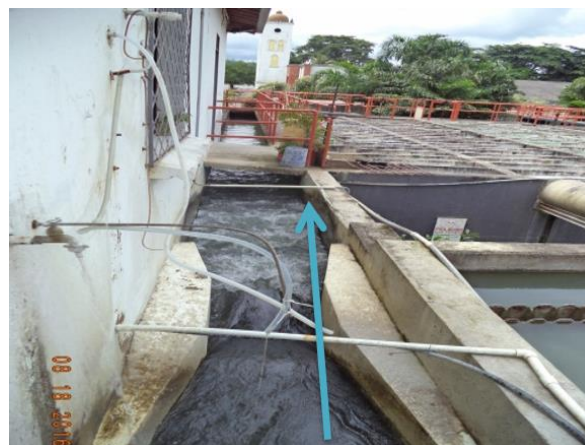
Ilustración 13 canaleta Parshall
