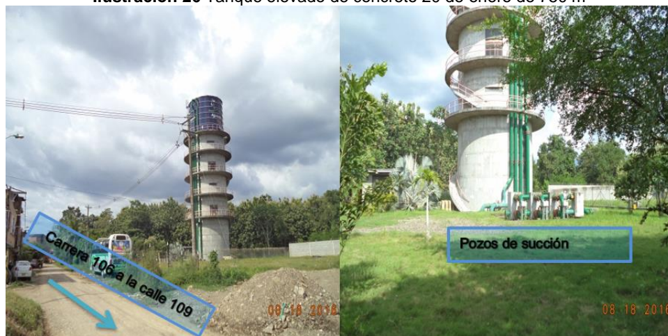
Ilustración 27. Tanque elevado de concreto Laureles 750 m 3
