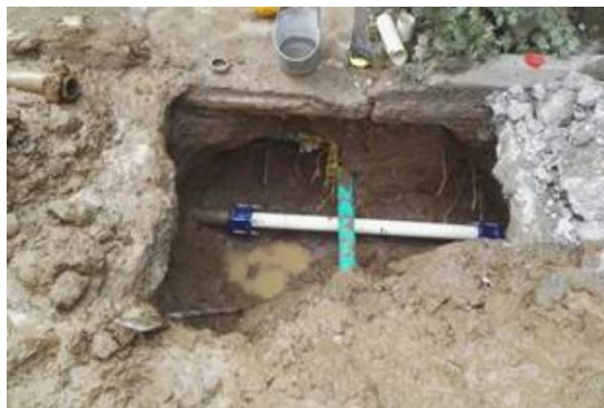
Ilustración 41 Reparación de fuga 3" asbesto cemento al frente de la emisora apartado estéreo y Colanta, circuito 45/080350. Carrera 101A entre Calle 99 y Río Apartadó.
